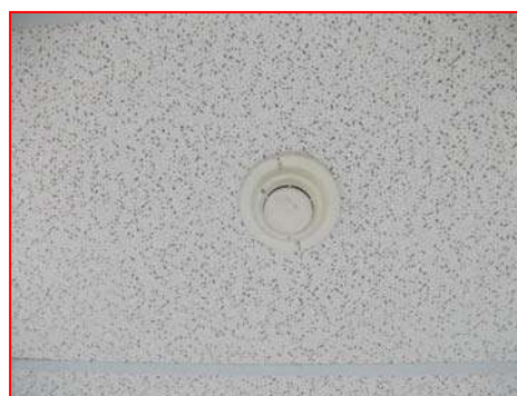
ภาพที่ 2.2-34 Smoke and Heat Detector
