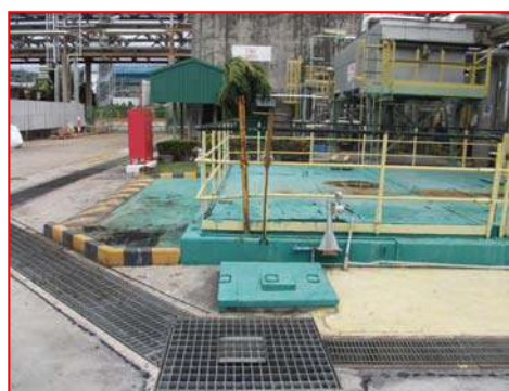
ภาพที่ 2.2-13 บ่อรับน้ำปนเปื้อนน้ำมัน
