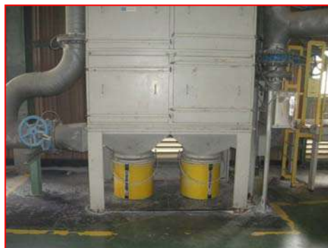
ภาพที่ 2.2-6 ระบบบำบัดแบบถ่วงกรอง (ระบบสำรอง)
