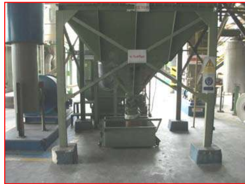
ภาพที่ 2.2-5 ระบบบำบัดแบบถ่วงกรอง (ระบบหลัก)
