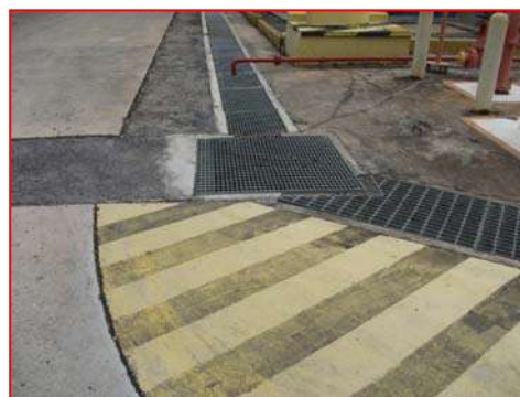
ภาพที่ 2.2-11 รางระบายน้ำฝนปนเปื้อนน้ำมัน
